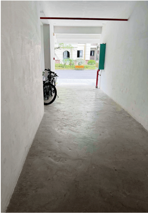
该小区10栋一楼公共走道现状。
