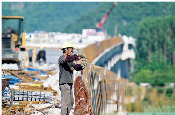
工人顶着烈日在屯秋铁路跨线桥上施工。
