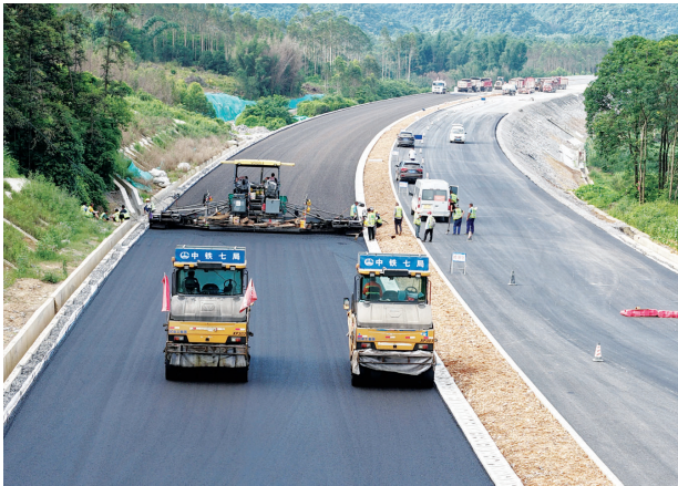
工人驾驶设备铺设沥青。
