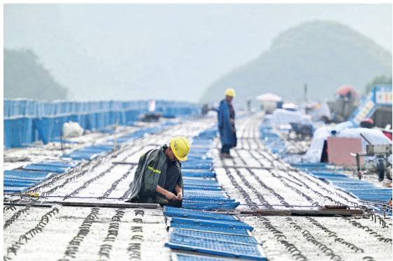
阵雨来袭，工人冒雨在屯秋铁路跨线桥上绑扎钢筋。
