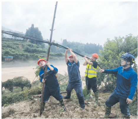
应急抢险队维修通信设施。 (通信运营商供图)
