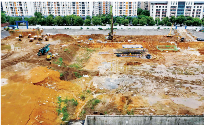
该小区二期工地已动工。
