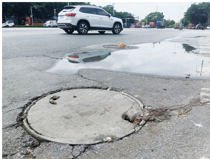
反流污水的下水道井盖。
