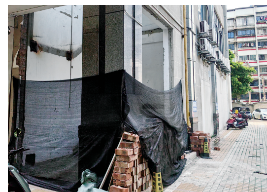
施工现场被围起施工网。
