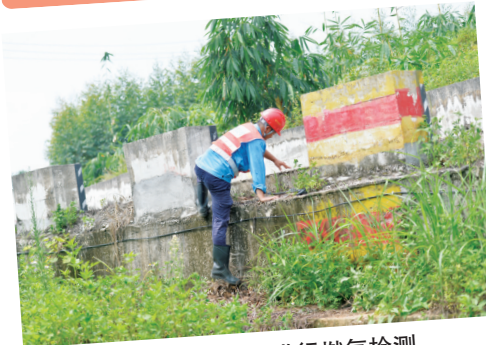
秦远洋爬过高处进行燃气检测。
