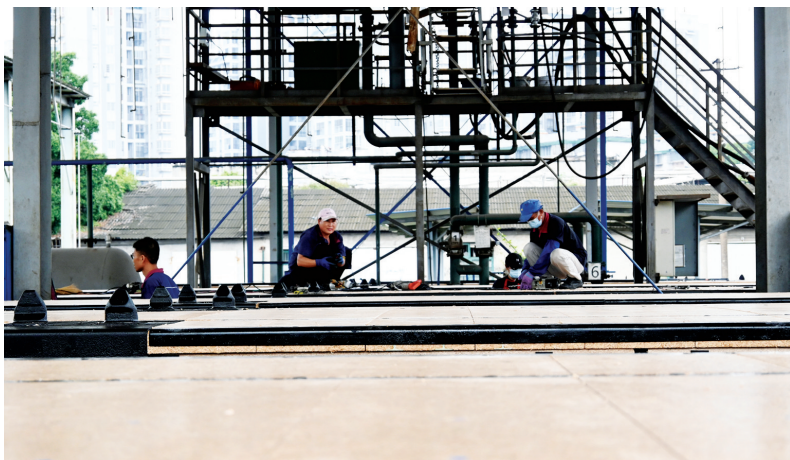
工人给平车安装木板。
