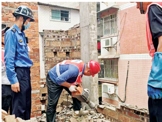
执法人员监督工人进行拆除。
