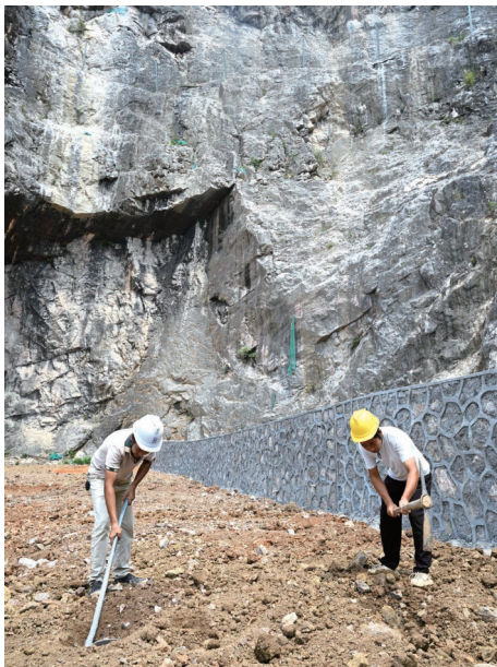
在融安县长安镇红卫村附近，一座废弃矿山主体工程完工，工人在覆土的矿洞上开坑，为种植绿植做准备。
