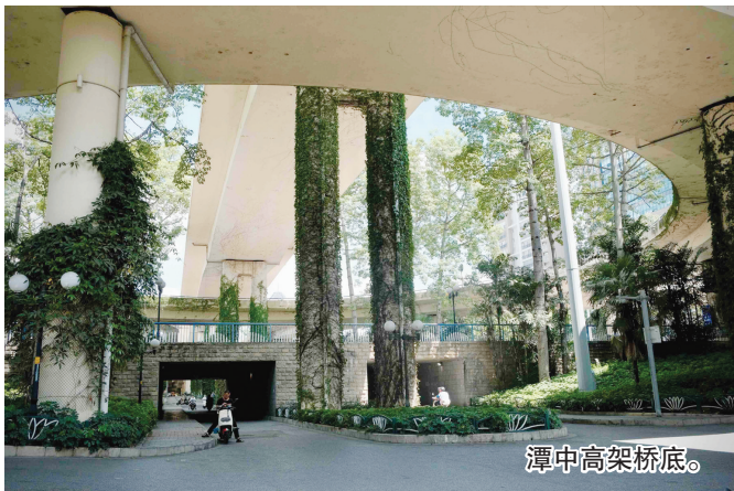
曙光大道立交桥底。
