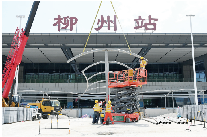
柳州火车站西广场前，工人在吊装膜结构。
