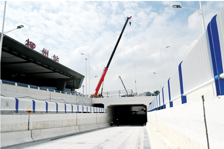
建设中的下穿通道。
