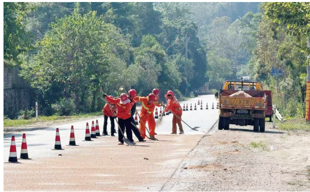
演练现场，工作人员在清理路面。
