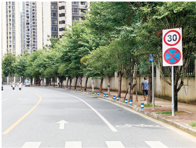
加装水泥桩后，违停乱象得到治理。
