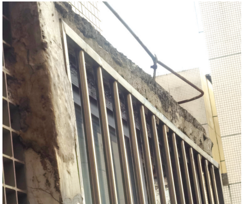
黄女士家卧室窗户上方窗檐的灰浆带已脱落。
