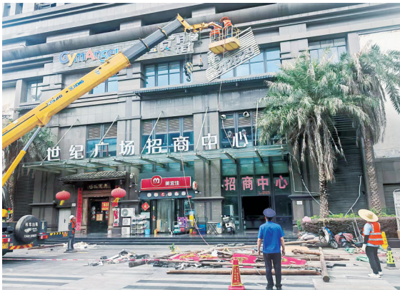
执法人员监督工人拆除废旧广告牌。
