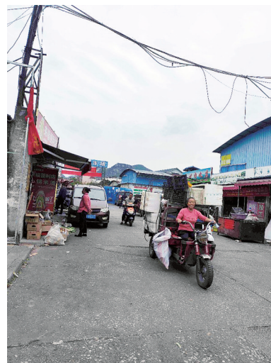
正在拆除的航鹰过渡市场。
