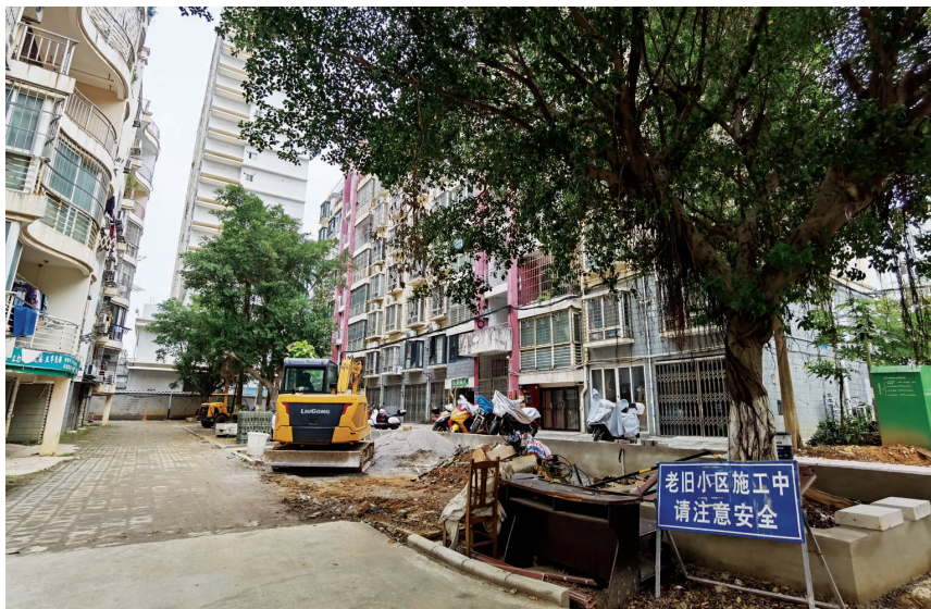
正在改造的潭中明园北园。
